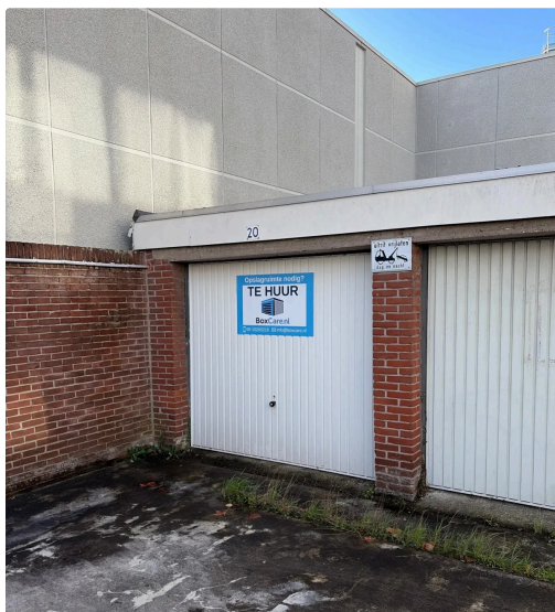
Garagebox met kanteldeur
